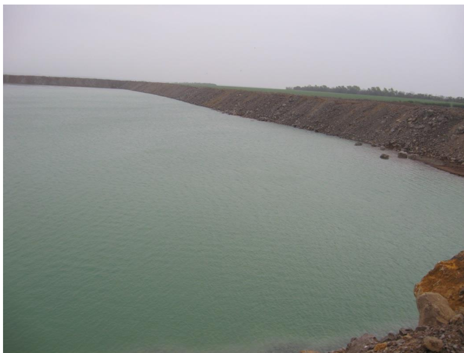
Рис. 24. Новое хвостохранилище (фото автора)
