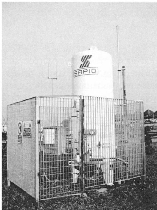
*Рисунок 1.7. Общий вид стационарного жидко-азотного генератора*
